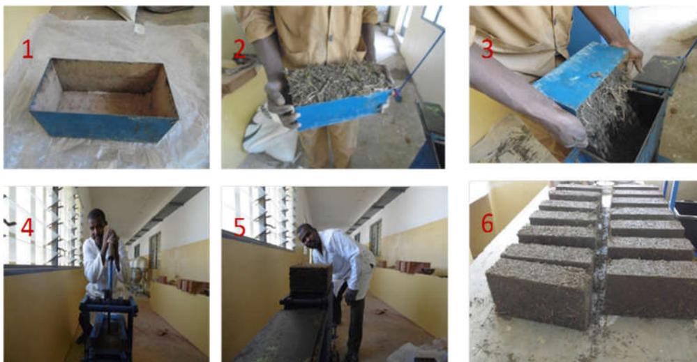
**Figure 5 :** *Procédure de préparation des briques BTC*
