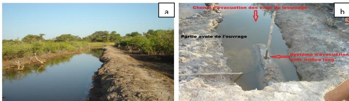
**Figure 3 :** Barrage anti-sel traditionnel diola et orifices de régulation de la retenue d'eau : a. Barrage anti-sel traditionnel diola à Diantène b. Système de régulation avec orifice long
