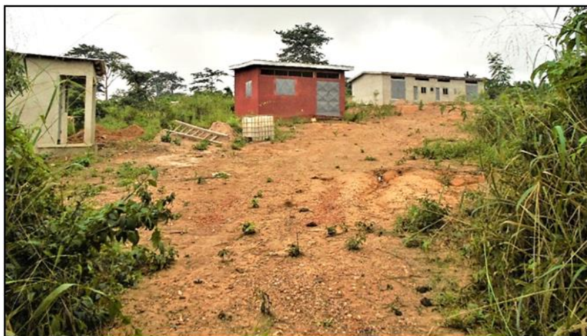
Figure 5 : Unités de transformation de manioc en construction à la périphérie de la ville de Bocanda
