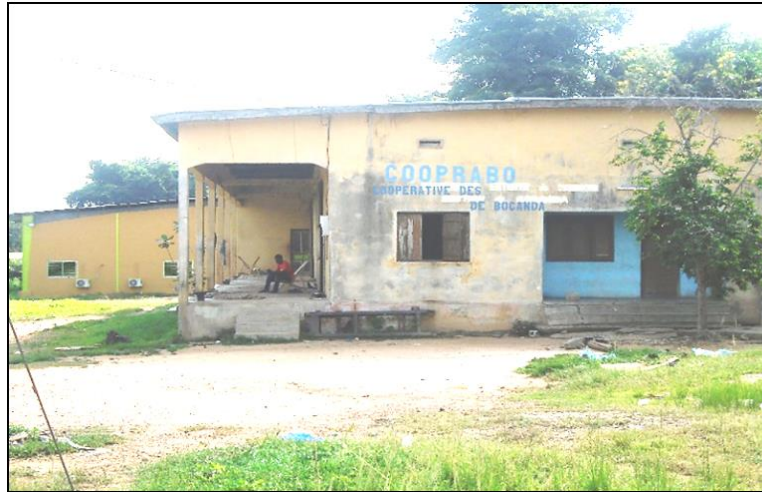
Figure 3 : Magasin de stockage des produits vivriers dans la ville de Bocanda
