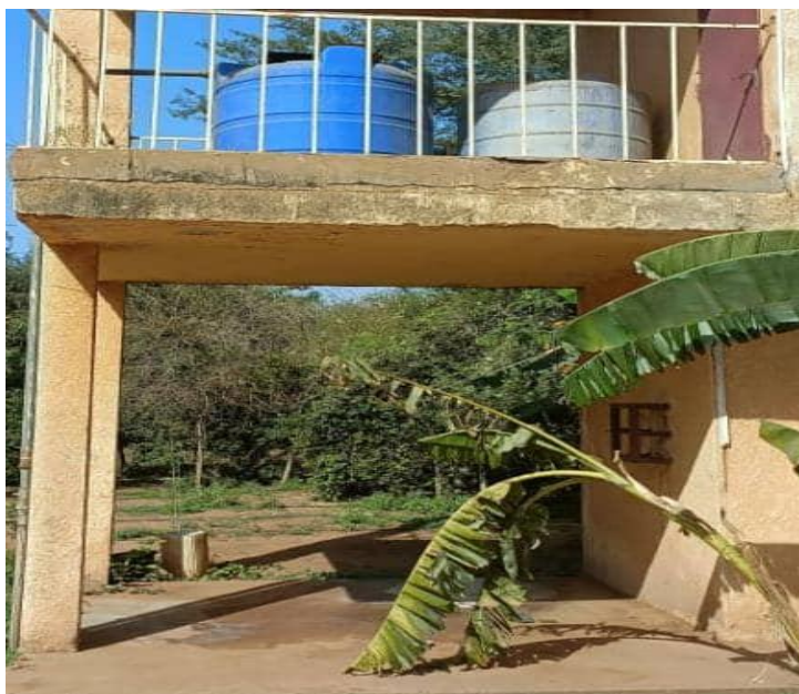
Figure 4 : Réservoirs de stockage
