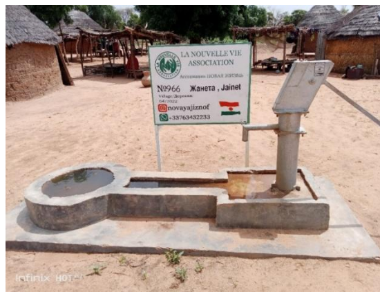
Photo 1 : Ouvrage hydraulique réalisé par une ONG caritative Source : Travaux de terrain, 2022
