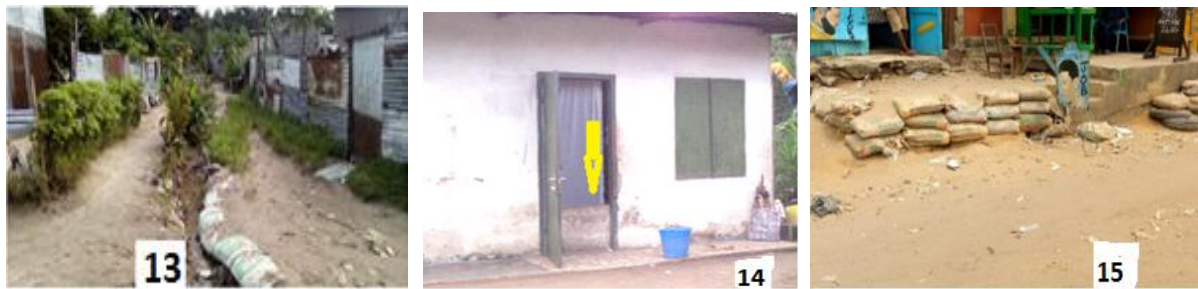
Figure 7 : Méthodes de résilience face aux inondations ( P_{13} : sillon aménagé au milieu de la voirie pour la canalisation des eaux pluviales à Matari ; P_{14} : mur en briques construit devant la porte d'une maison à Matari ; P_{15} : digue de sacs remplis de sable érigée devant la maison pour la protéger de la montée des eaux). © : Sítou, 2021
